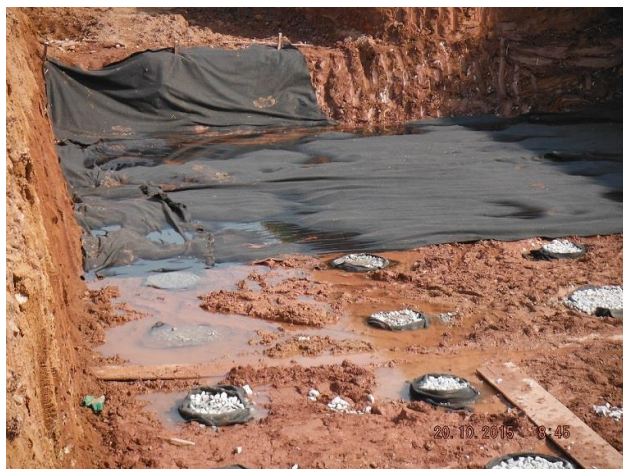
Figura 6. Execução das Colunas de Brita Envelopadas com Geotêxtil.
