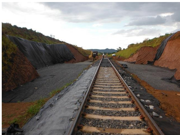
Figura 7. Execução da obra.
