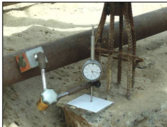
Figura 12: Disposição dos extensômetros nas estacas de reação.
