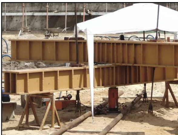
Figura 8: Montagem do sistema de reação.
