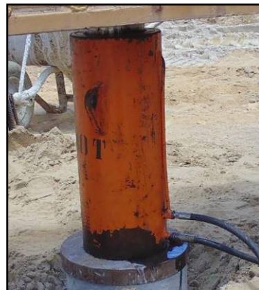
Figura 10: Macaco Hidráulico
