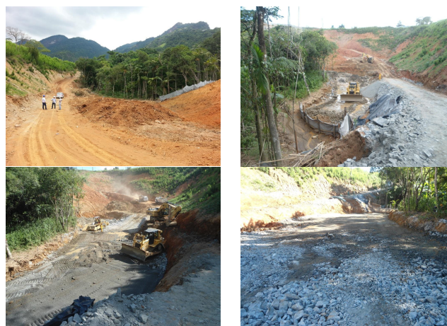
Figura 5. Escavação e troca de solo da base
