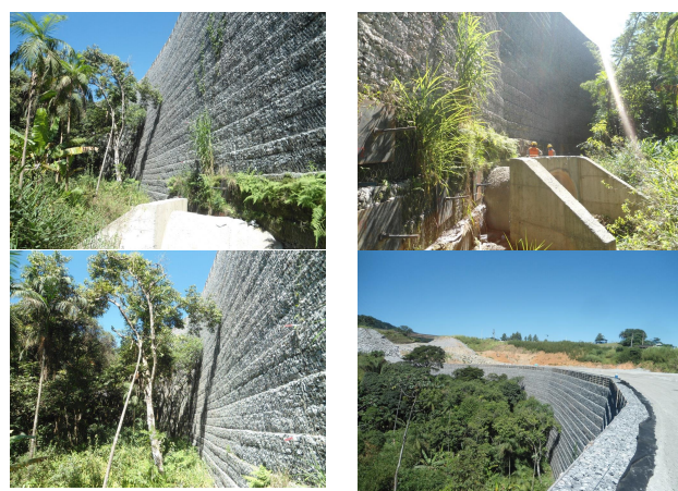
Figura 6. Vista do paramento frontal da estrutura.
