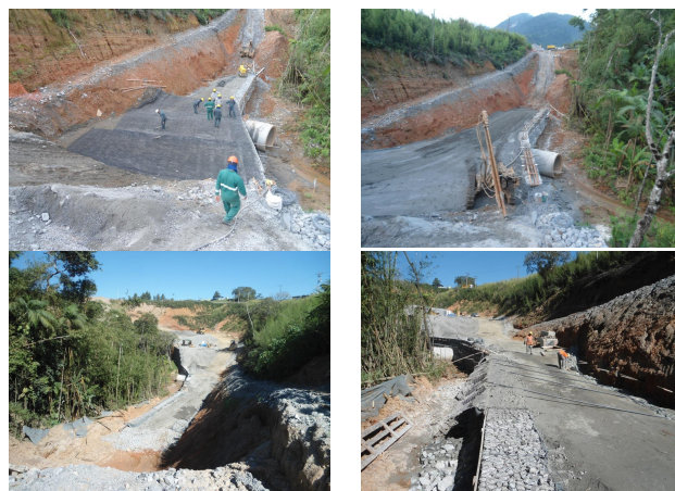
Figura 8. Vista do paramento frontal da estrutura.
