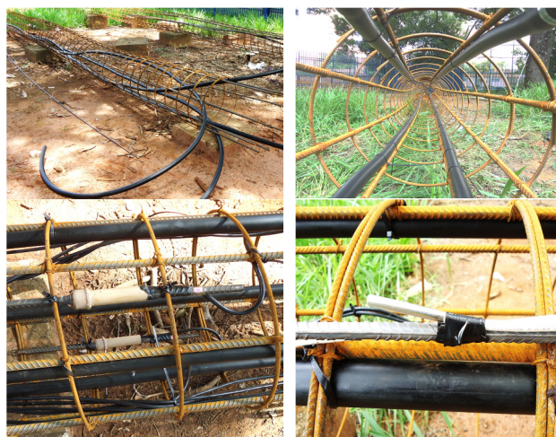
Figura 7. Montagem da estaca trocadora de calor.
