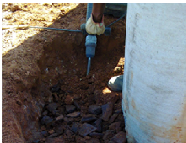
Figura 10. Utilização de martelete para transpassar a camada de concreção de limonita.
