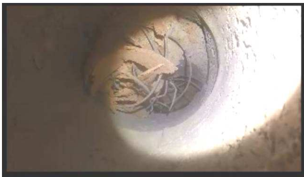
Figura 19. Seccionamento completo, na estaca PB04E, com desalinhamento entre as porções.
