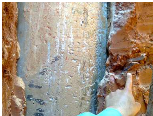
Figura 16. Detalhe da camada de concreção de limonita na região da estaca cravada
