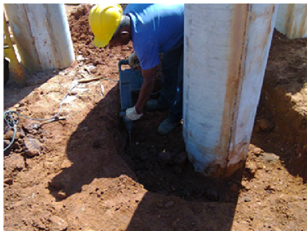
Figura 9. Utilização de martelete para transpassar a camada de concreção de limonita
