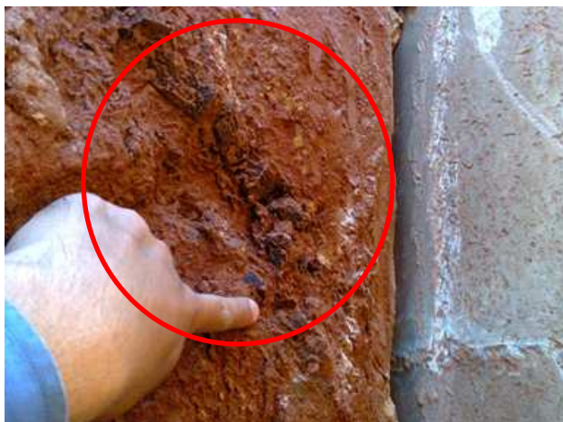
Figura 17. Detalhe da camada de concreção de limonita na região da estaca cravada
