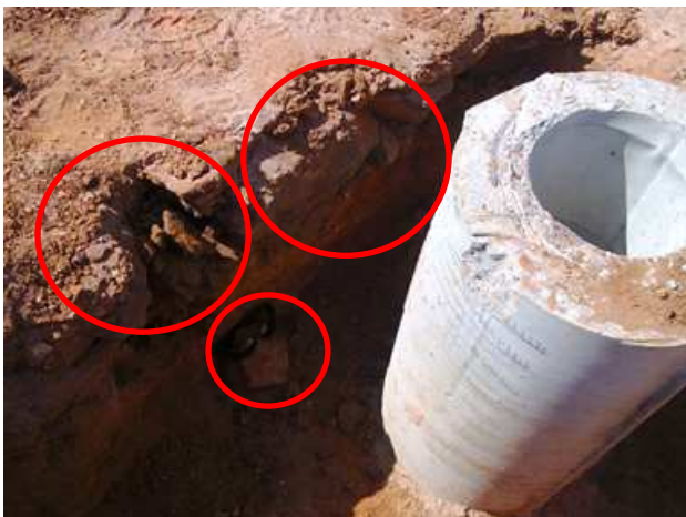
Figura 12. Ocorrência de concreção de limonita durante a escavação do bloco de coroamento
