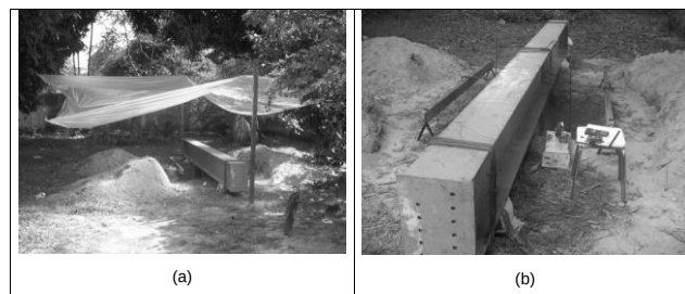
Figura 2. Ensaio de prova de carga direta em placa (BURNET, 2007).
