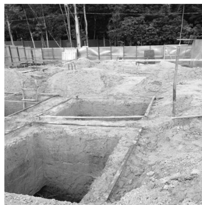
Figura 5: Abertura das sapatas escavadas
