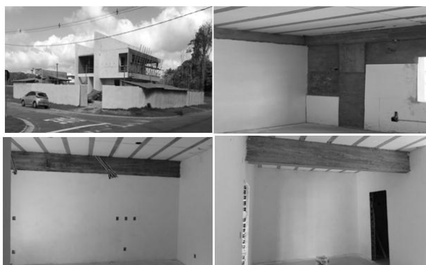
Figura 9: Vistas da fachada, vigas, pilares e lajes, em condições perfeitamente satisfatórias, sem registro de nenhum tipo de patologia
