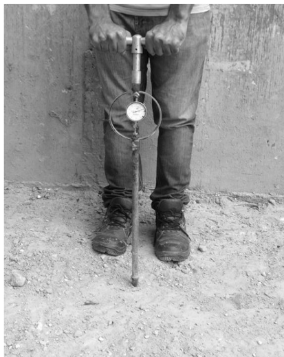
Figura 3. Cravação do CPE na cota de assentamento
