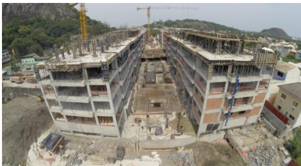
Figura 16. Vista geral da obra. Detalhe do subsolo já executado (21/10/2015).
