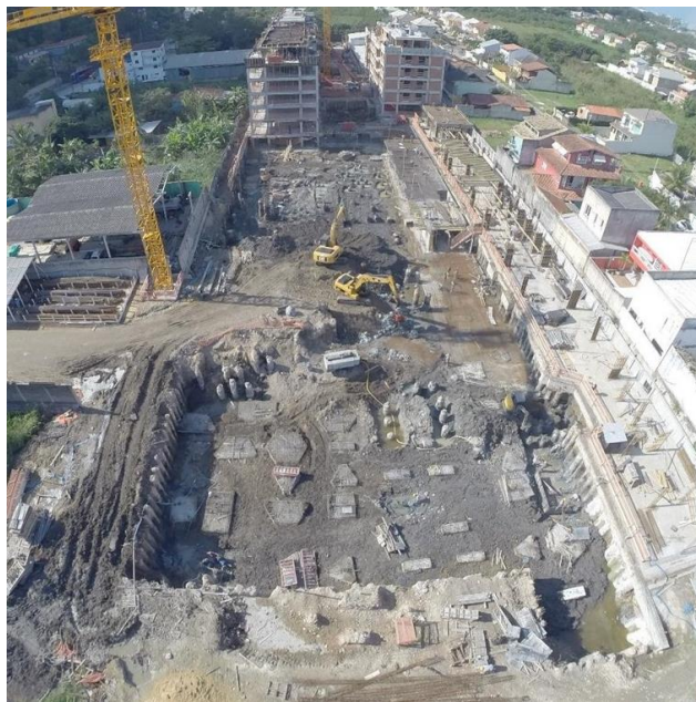
Figura 7. Vista geral da obra de escoramento provisório.
