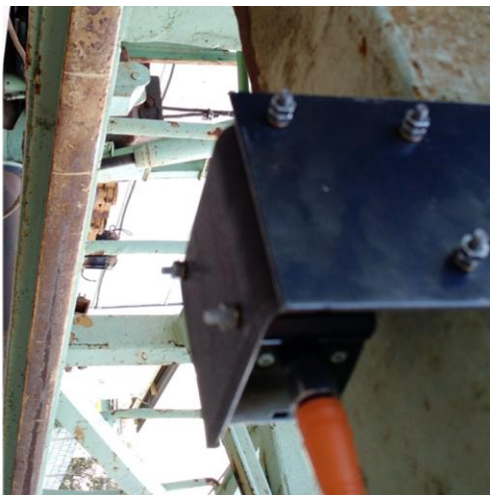
Figura 1. Sensor laser instalado no alto do bate-estacas
