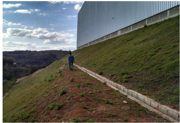
Figura 3. Vista geral do galpão e do talude de aterro analisado
