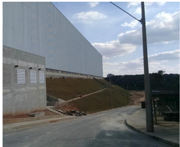
Figura 4. Vista geral do galpão e do talude de aterro analisado
