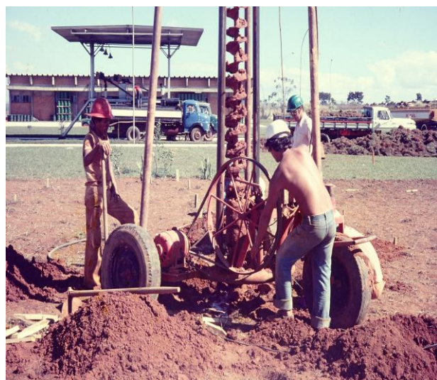
Figura 5. Escavação Mecânica: Equipamento de Fabricação Artesanal
