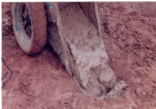
Figura 9. Lançamento SCP
