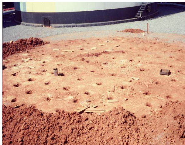
Figura 4. Aplicação do SCP Como Apoio para Radiers de Tanques de Petróleo
