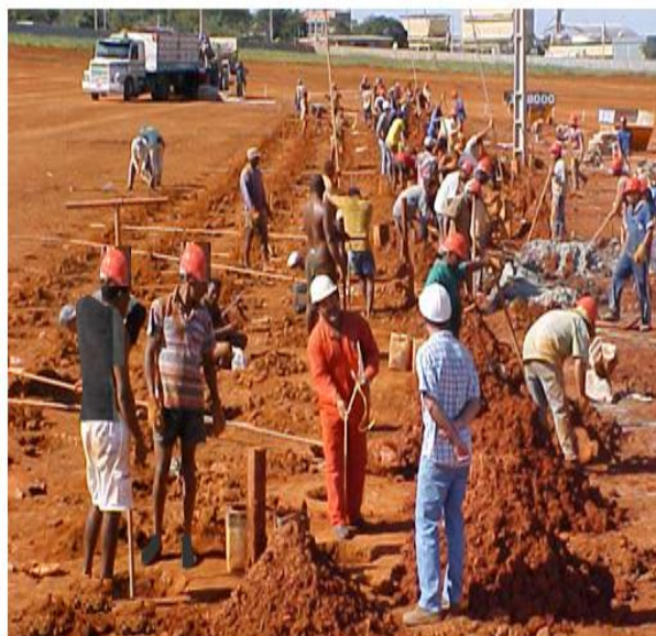
Figura 2. Escavação Manual das Estacas Em SCP
