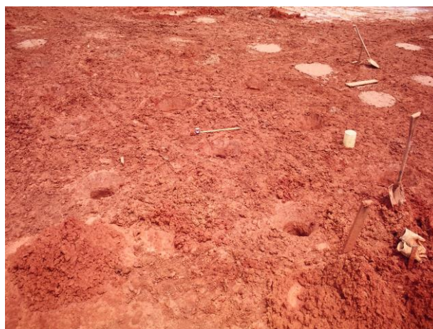
Figura 5. Utilização Do SCP para Melhoria do Subleito para Aterros Rodoviários
