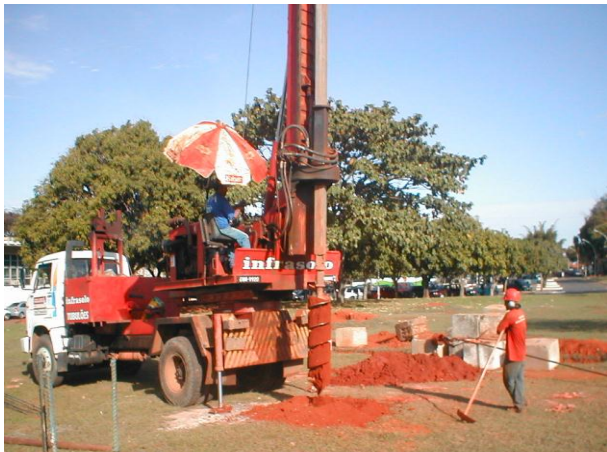
Figura 3. Escavação Mecânica da Estaca
