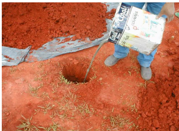
Figura 8. Consolidação do Solo Fofo
