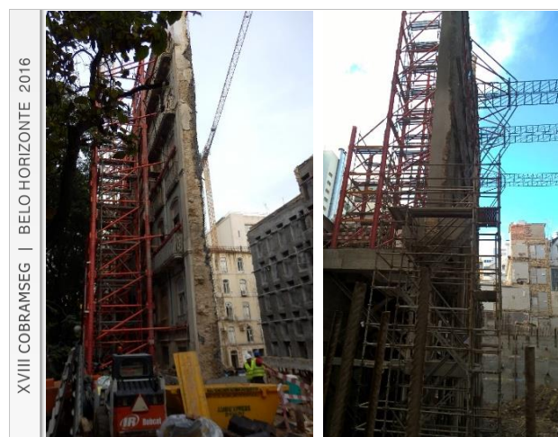
Figura 6 – Vistas das estruturas de contenção de fachadas.
