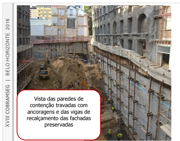
Figura 9 – Vistas da parede de contenção periférica, com recurso a ancoragens pré-esforçadas
