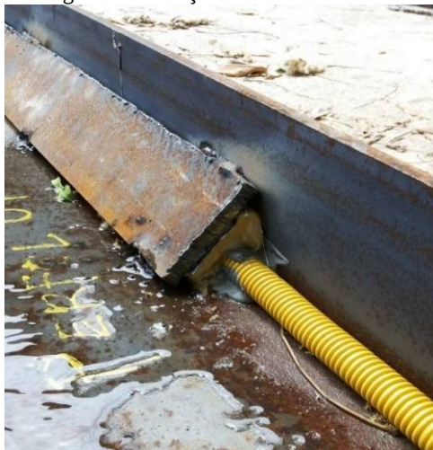
Figura 4 - Proteção dos conduites
