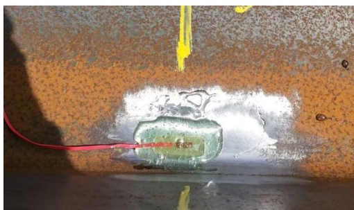
Figura 3 - Proteção dos extensômetros
