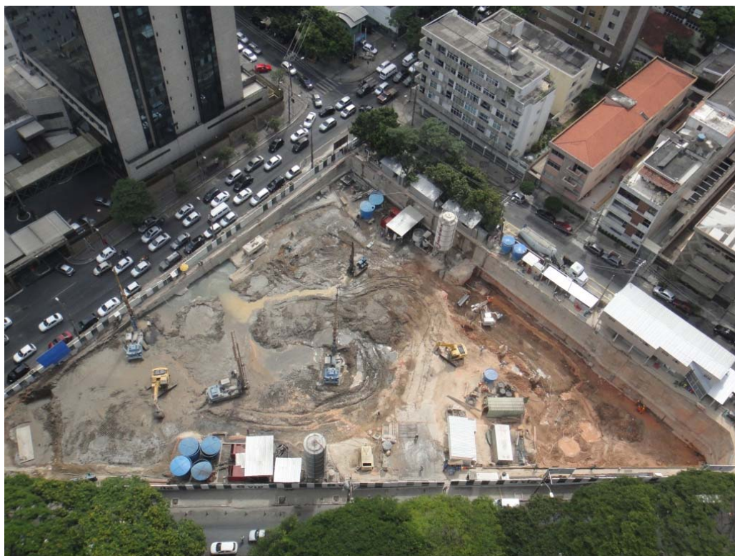
Figura 4. Vista aérea da fase de execução do Jet Grouting na Forluz
