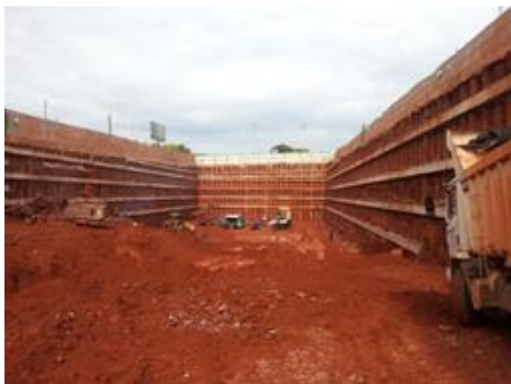
Figura 2. Exemplo de parede em estaca escavada.
