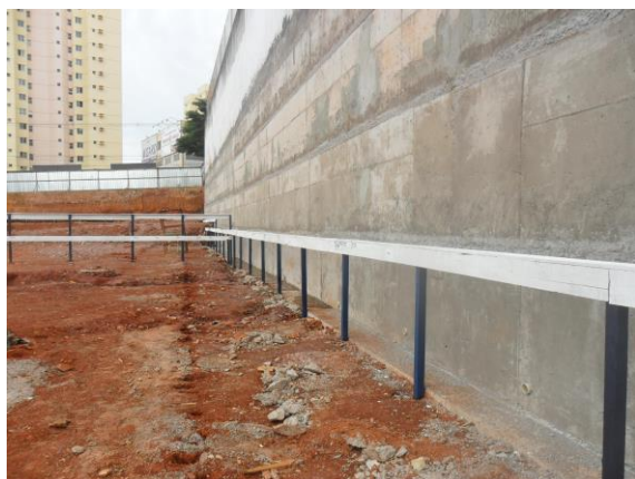
Figura 1. Exemplo de parede estruturada.
