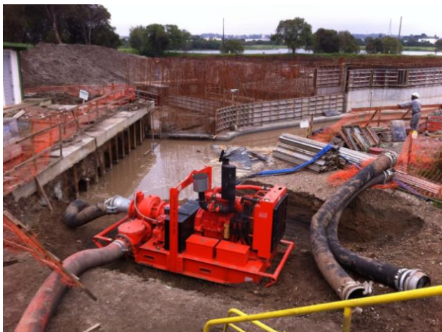
Figura 9 – Contenção lateral em perfis de aço e bomba de recalque em primeiro plano.
