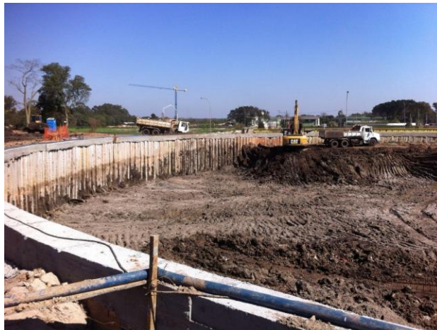
Figura 7 – Fase de escavação do DS 3.
