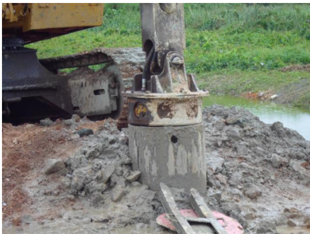
Figura 5 – Cravação de tubo camisa de poço de rebaixamento.
