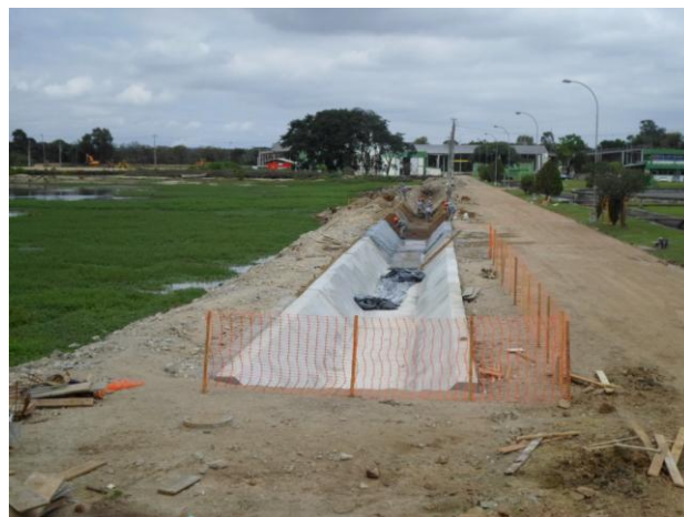
Figura 10 – Construção do canal de deságüe.
