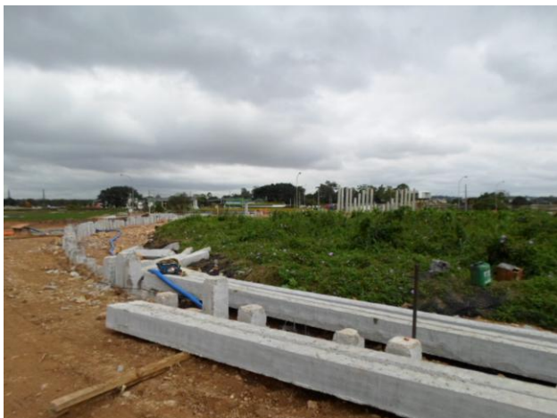
Figura 6 – Execução da cortina envoltória do DS 3.
