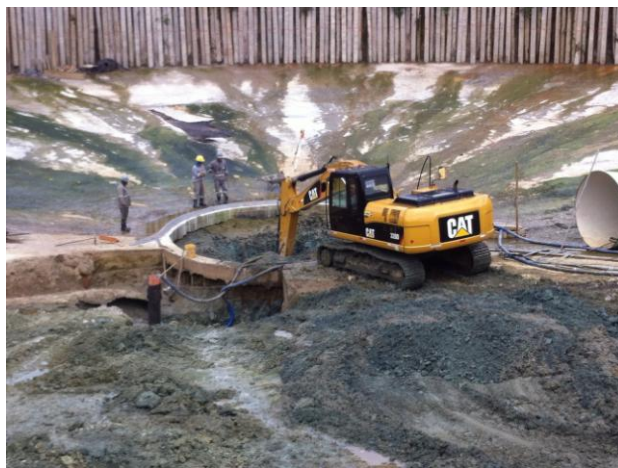
Figura 8 – Rebaixo da tubulação de entrada do DS 3.
