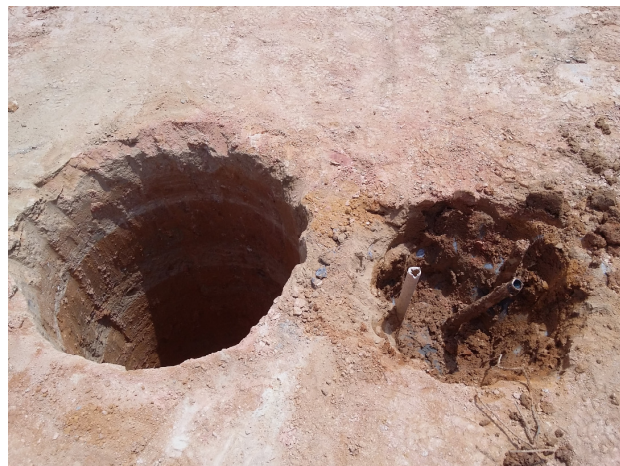
Figura 5. Escavação adjacente a estaca ensaiada
