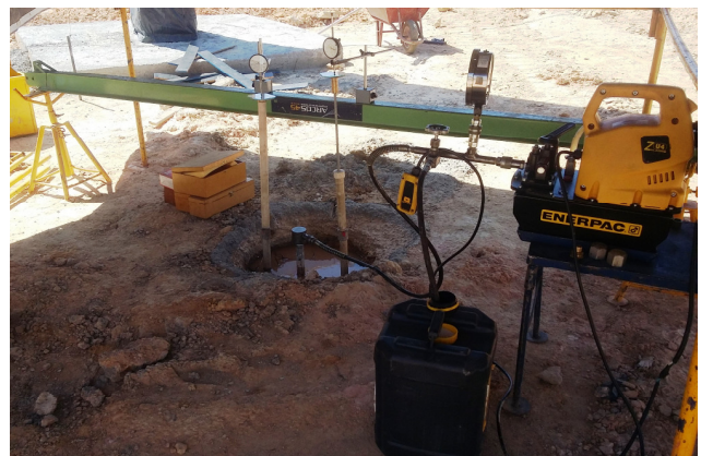
Figura 3. Prova de carga estática com célula expansiva hidrodinâmica em andamento
