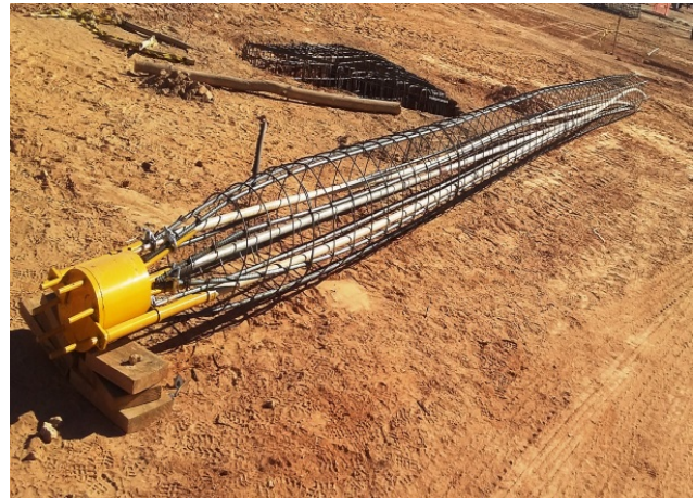
Figura 2. Instalação da célula hidrodinâmica na armação da estaca
