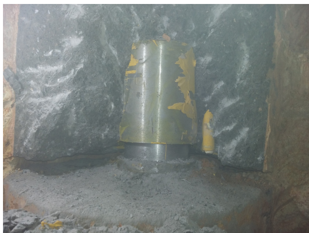
Figura 8. Extração da célula de carga e verificação da integridade do elemento de fundação.
