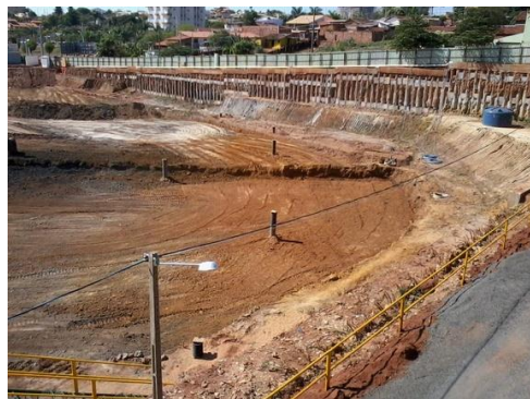
Figura 6. Situação após o rebaixamento.
