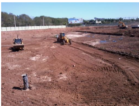
Figura 5. Situação após o rebaixamento.
