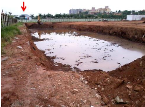
Figura 3. Comparação. Situação antes do rebaixamento.
