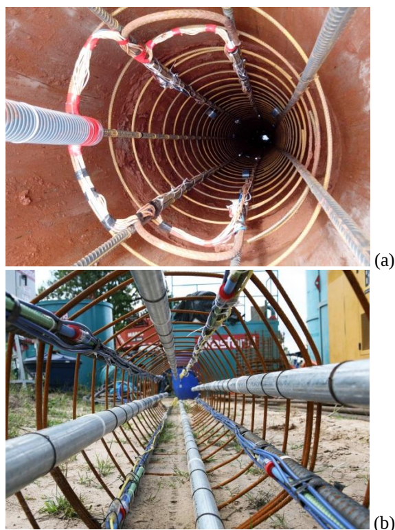
Figura 4. (a) Strain-gages resistivos (primeiro caso de obra) e (b) Strain-gages de corda vibrante (segundo caso de obra) instalados na armadura da estaca.
