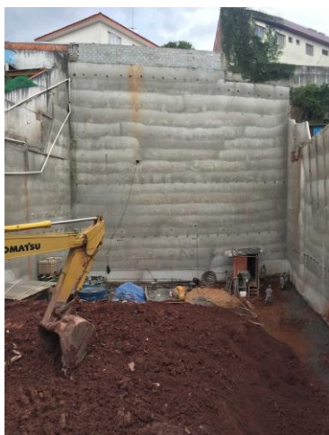
Figura 1 – Contenção com 20 m de altura.
