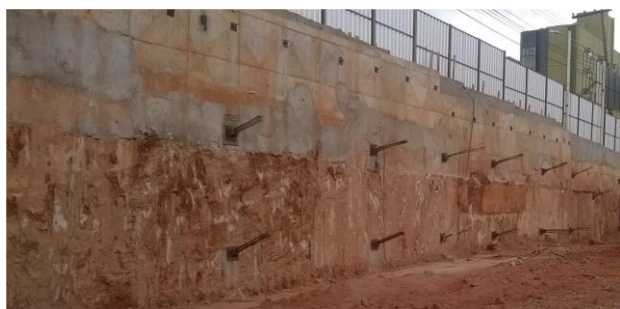
Figura 1. Parede Diafragma Moldada in loco atirantada em processo de escavação.
