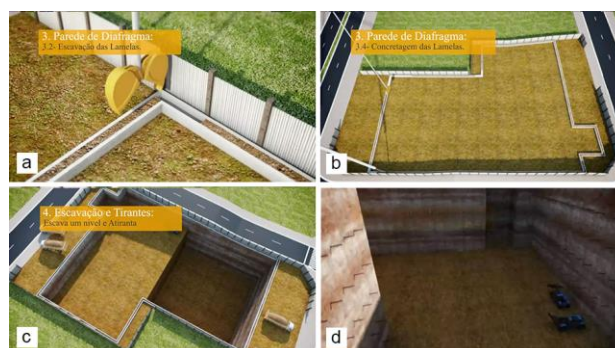
Figura 6. Figura 24. Processo executivo: (a) Escavação das paredes definidas pelas muretas-guia; (b) Concretagem das lamelas; (c) Escavação e atirantamento de cada nível; (f) Fundo da escavação
