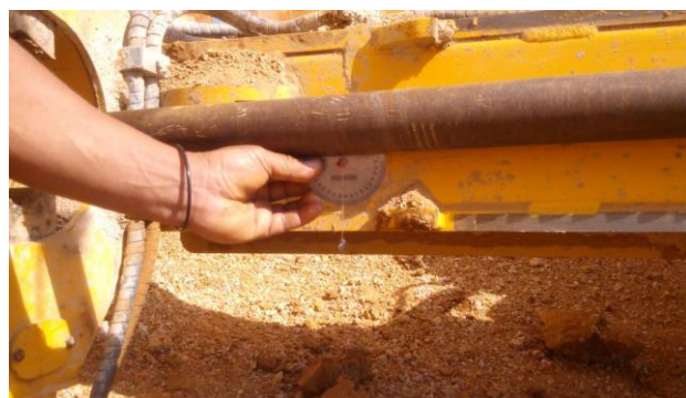
Figura 5. (a) Execução de chumbador teste, (b) Controle do grau de perfuração.
