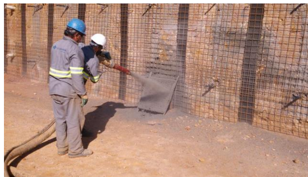
Figura 7. Moldagem de placa de concreto projetado para verificação de resistência axial.
