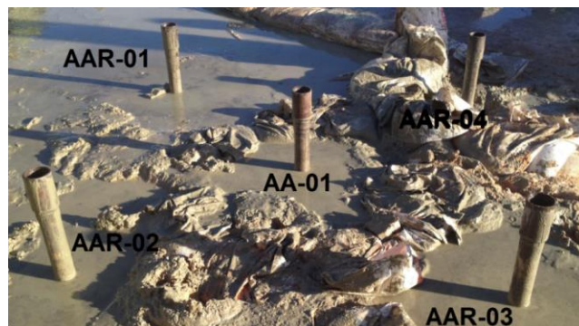
Figura 4. Microestacas executadas para montagem PCE.
