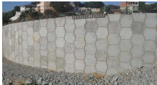
Figura 9. Contenção em terra armada.
