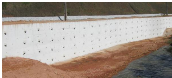
Figura 4. Contenção em cortina atirantada.
