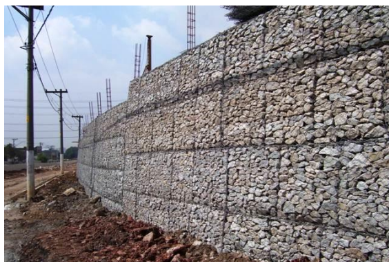
Figura 6. Contenção em gabião.
