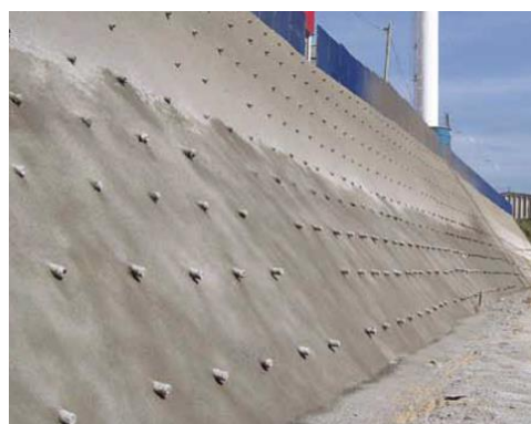
Figura 2. Contenção em solo grampeado.
