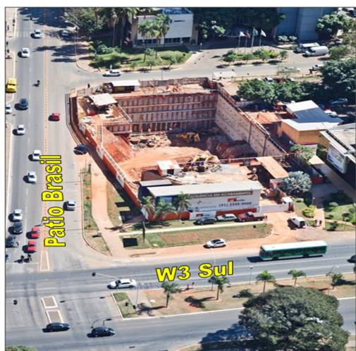
Figura 4 - Localização da obra em relação ao Shopping Pátio Brasil e avenida W3 Sul.
