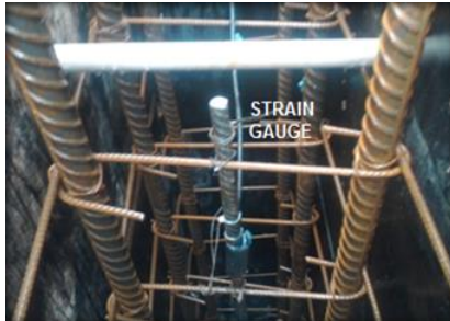
Figura 3.3 Strain Gauge instalado nos pilares
