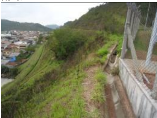
Figura 5. Aspecto geral do talude de jusante ao reservatório
