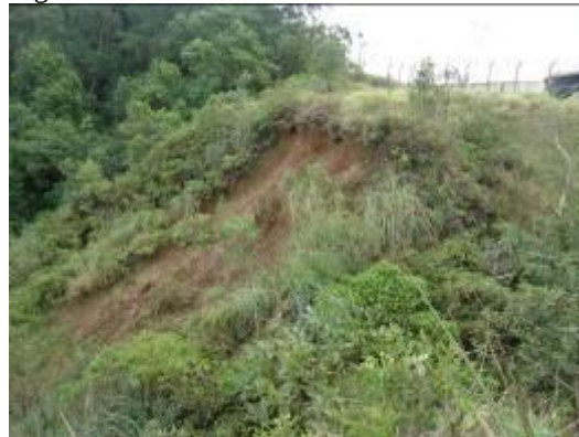
Figura 3. Deslocamento de massa observada a montante do reservatório
