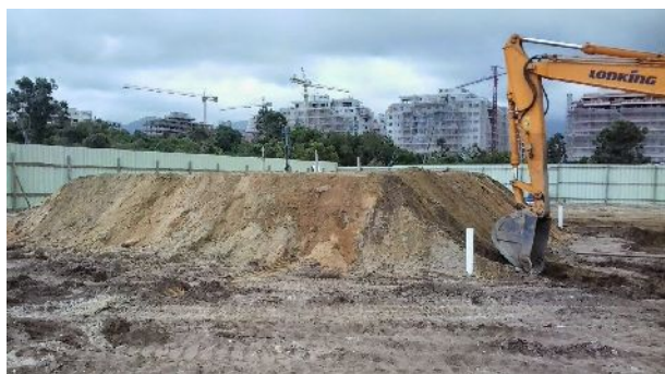
Figura 8. Aterro teste finalizado, com os instrumentos instalados e sobrecarga aplicada
