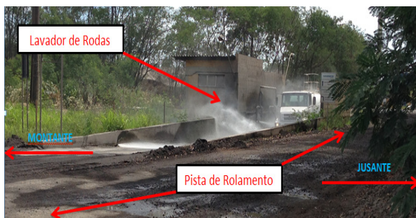
Figura 4. Montante e Jusante do talude.
