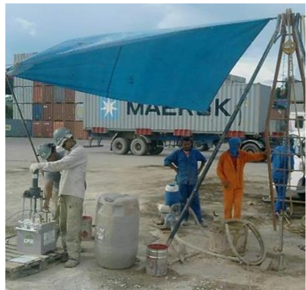
Figura 14. Análise pressiométrica executada na área pavimentada da Zona Portuária.
