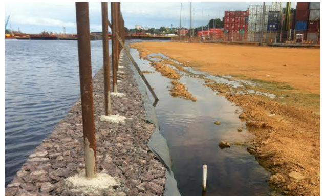
Figura 10. Área portuária tratada com CPR Grouting e com muro gabião com cerca de 8m de altura definindo o novo cais. Notar que o nível do rio está em sua cota máxima e o aterro apenas aguardando a base granular para assentamento do piso de concreto. Ver detalhe do projeto na figura 10.
