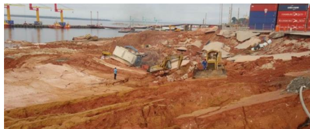
Figura 2. Situação de ruptura típica da região portuária de Manaus.
