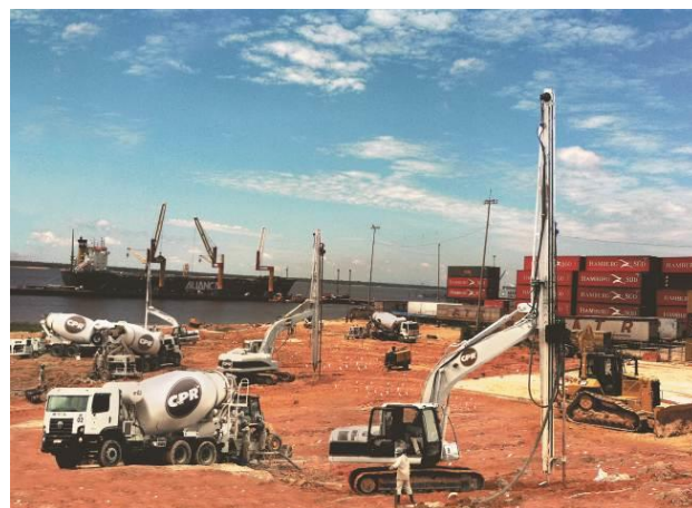
Figura 8. Panorama dos serviços CPR Grouting na Zona Portuária, pós-ruptura.
