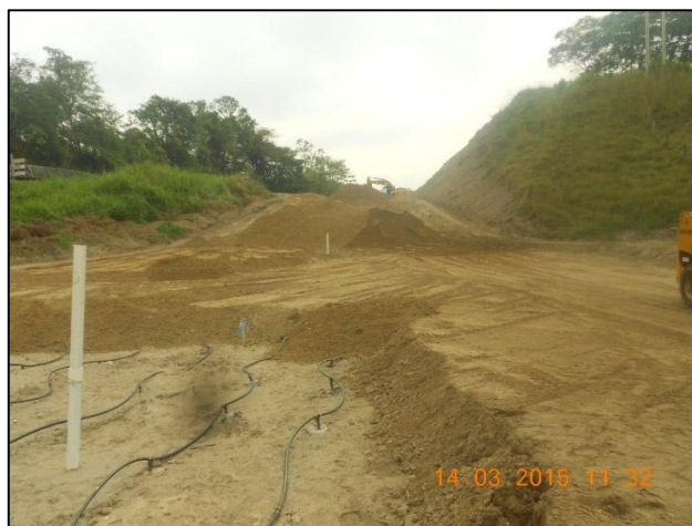
Figura 6 – Execução da camada de proteção das mangueiras do sistema de vácuo.
