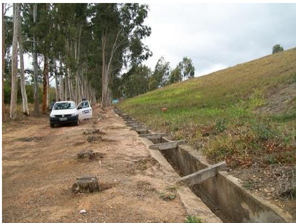
Figura 4. Levantamento do radargrama 22 sobre o perfil com cota de 4 m, na face jusante do corpo da barragem. Observar os tocos remanescentes das árvores cortadas.
