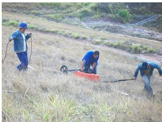
Figura 2. Levantamento de perfil GPR empregando antena de 200 MHz ao longo da cota de 23 m na face jusante do corpo da barragem.
